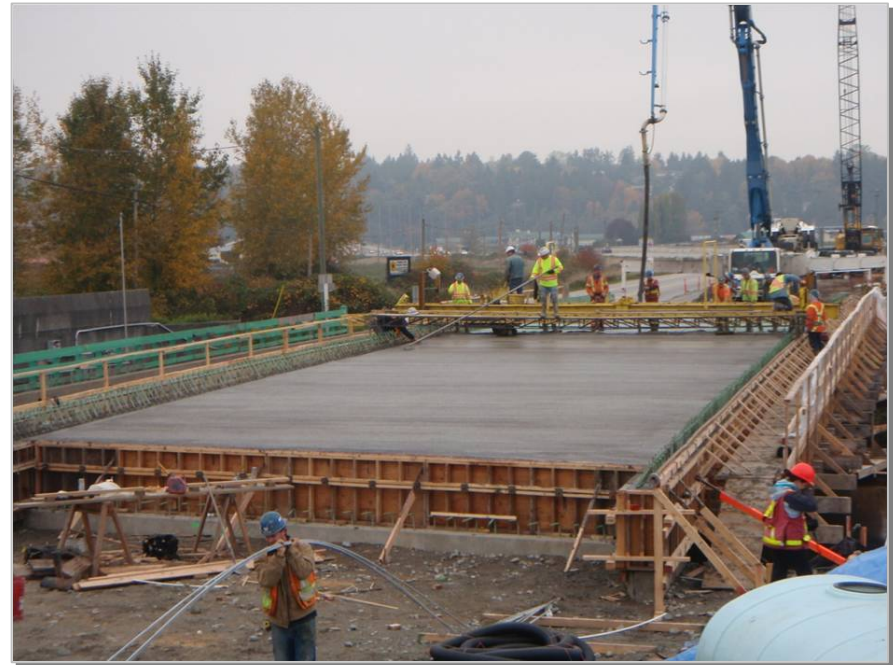
King George Blvd Bridge Concrete Deck Pour
